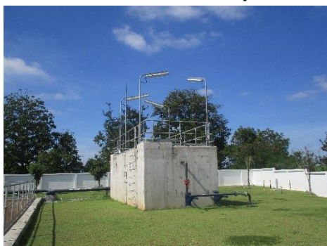
ภาพที่ 2-13 บ่อแยกน้ำ/น้ำมัน (Oil Separator)
