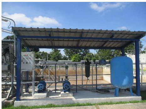
ภาพที่ 2-9 ระบบปั้มน้ำสำหรับรดน้ำต้นไม้
