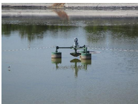
ภาพที่ 2-21 เครื่องเติมอากาศบริเวณอ่างเก็บน้ำทิ้ง
