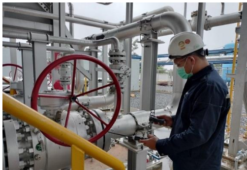
ภาพที่ 2-52 ตรวจสอบการรั่วไหลของท่อโดย Gas detector
