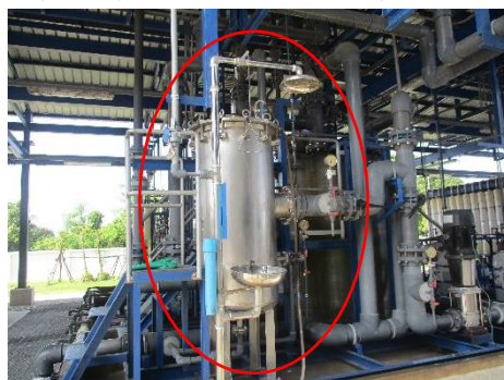
ภาพที่ 2-49 ฝักบัวอาบน้ำฉุกเฉิน และที่ล้างตาฉุกเฉิน
