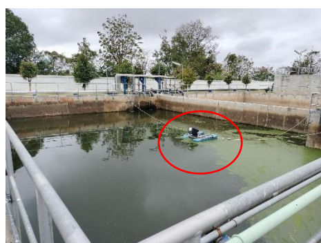
ภาพที่ 2-19 เครื่องเติมอากาศในบ่อพักน้ำทิ้งรวม
