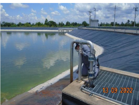
ภาพที่ 2-23 บ่อรวบรวมน้ำ (Sump) บริเวณอ่างเก็บน้ำทิ้ง
