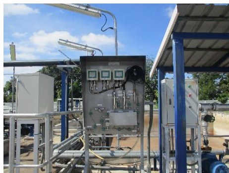
ภาพที่ 2-18 ระบบตรวจสอบคุณภาพน้ำแบบต่อเนื่อง (Online Monitor) บริเวณจุดระบายน้ำทิ้งของโรงไฟฟ้า
